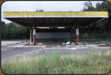
Bild 1: Ehemalige Tankstellen, Industriebereiche und Bahnanlagen sind oft Altlastenstandorte.
